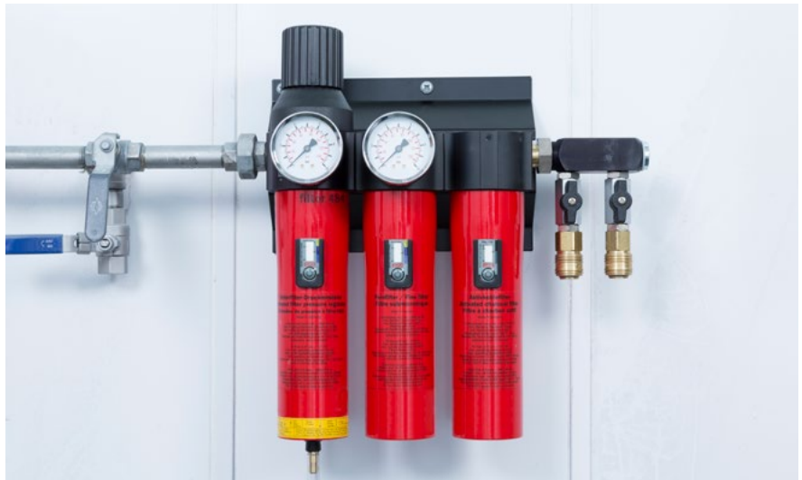
Abb. 13 Druckluft-Aufbereitung für fremdbelüftete Atemschutzgeräte mit Filterpatronenstandzeitanzeige
