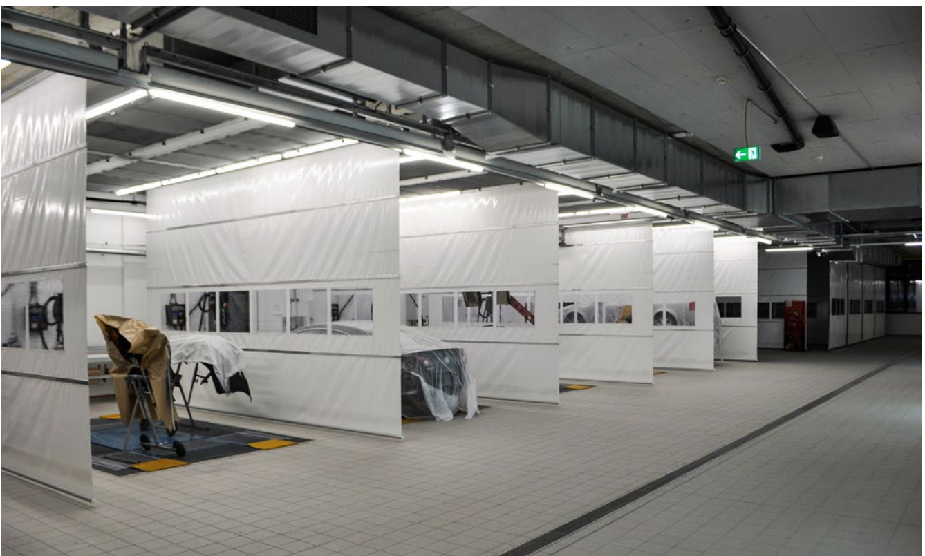
Abb. 1 Universal-Vorbereitungsbereich für die Kfz-Reparaturlackierung
